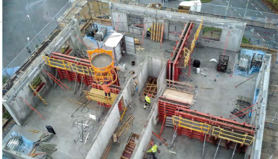
Projektet utförs i form av styrd totalentreprenad som hanteras av Nimab Entreprenad som totalentreprenör.
