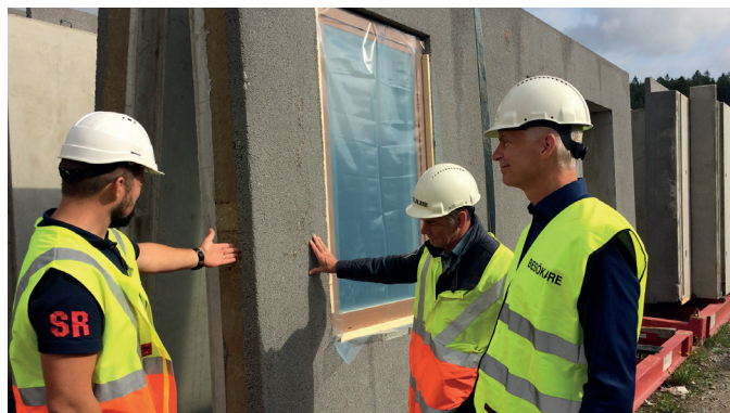
Andreas Ryrbo, produktionschef på Lättklinkerbetong, samtalar med Per Ingesson, från Skandinaviska Byggelement, och Johnny Johnsson från Peab PGS, om produktionen kring ytterväggar.
