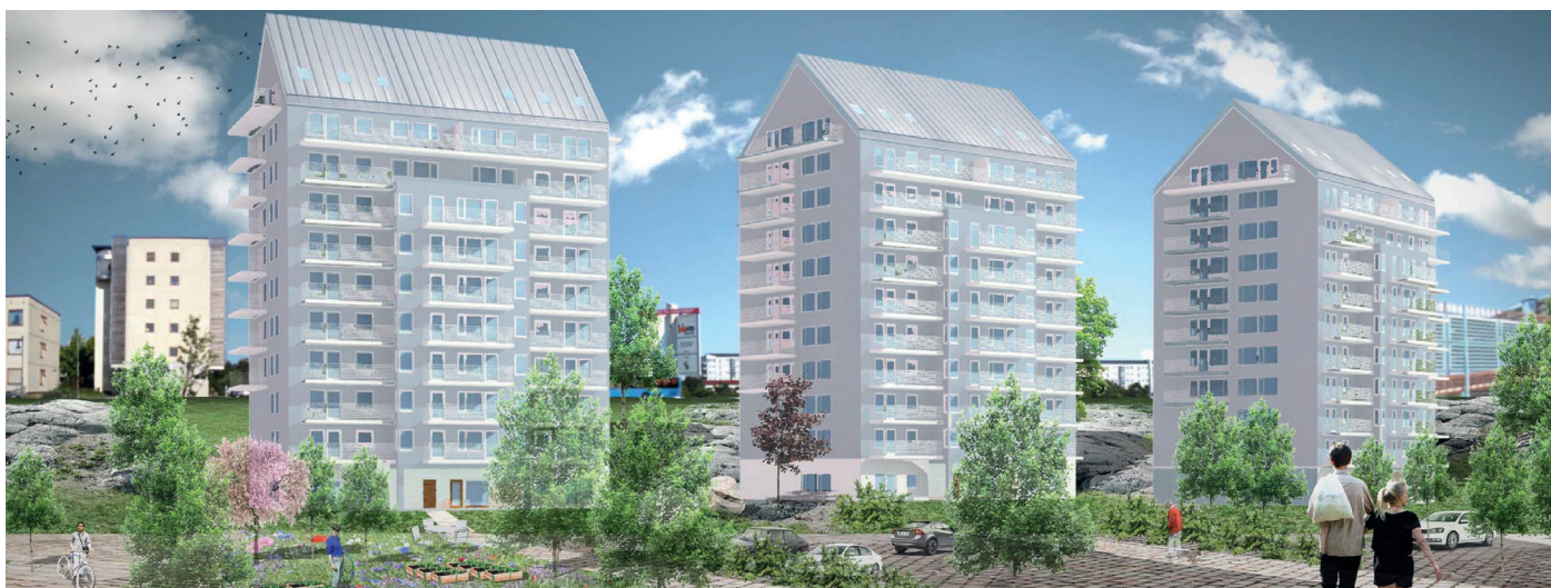
Projektet Kaneltorget i Göteborg byggstartades i Augusti 2015 med beräknad inflyttning under 2017.
