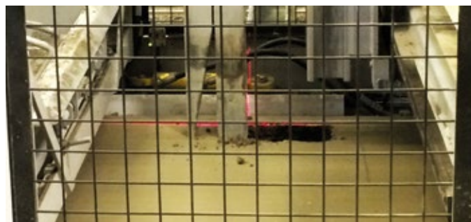
Slabmastern mäter maskinellt ut och gräver hål för ursparingar i håldäcket.
