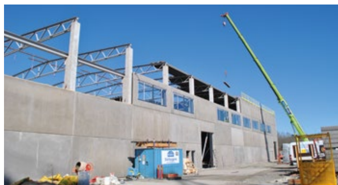
Bjälklag Kontur monteras på takstolarna till den nya fabriksdelen.
