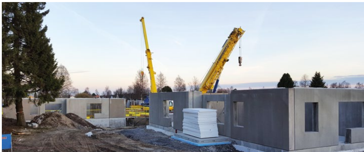
I Umeå monteras just nu nio Trygga Boendet av Lättklinkerbetong. Läs mer om projektet i Umeå på nästa sida.
