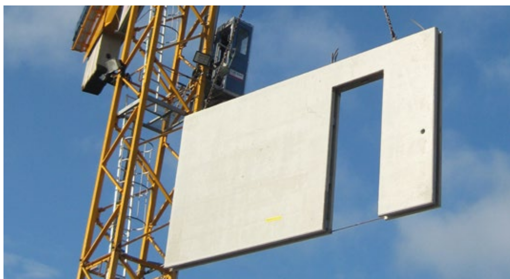
Skalvägg lyfts på plats för montering.
