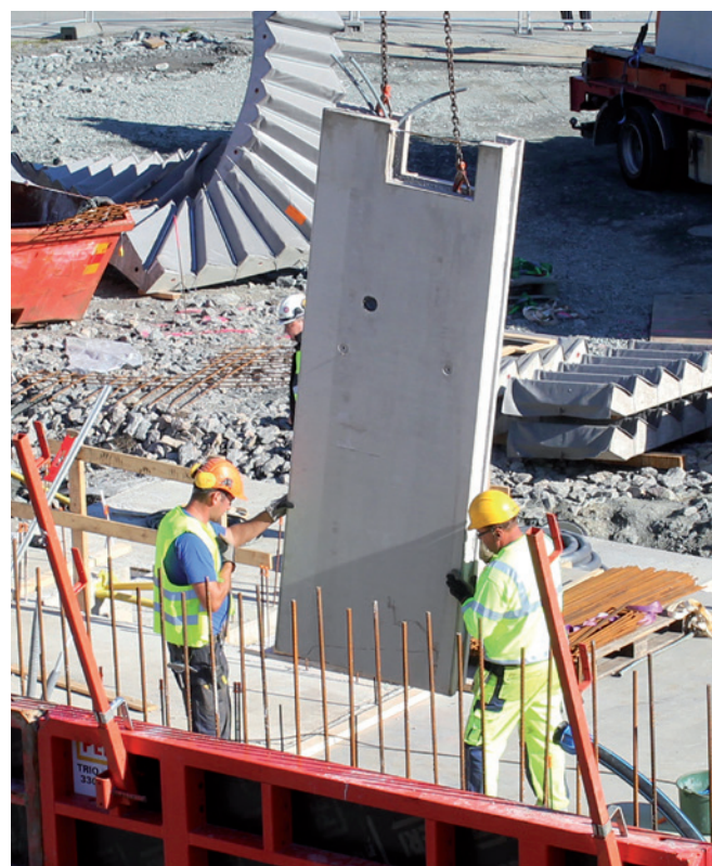
Våra betongelement monteras enkelt och smidigt på byggarbetsplatsen.
