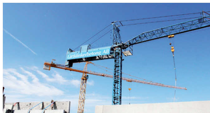
Lättklinkerbetongs byggkran över fabriken i Ucklum.
