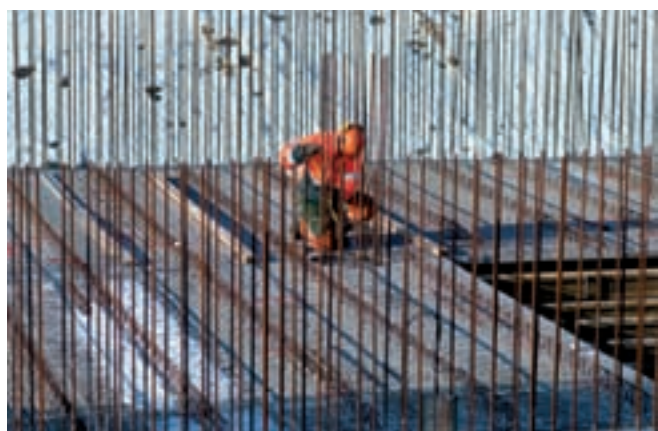
Tunneln byggs med plattbärlag från Skandinaviska Byggelement.
