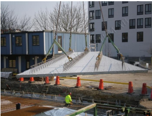
Figur 5, Montage plattbärlag -Skandinaviska Byggelement
