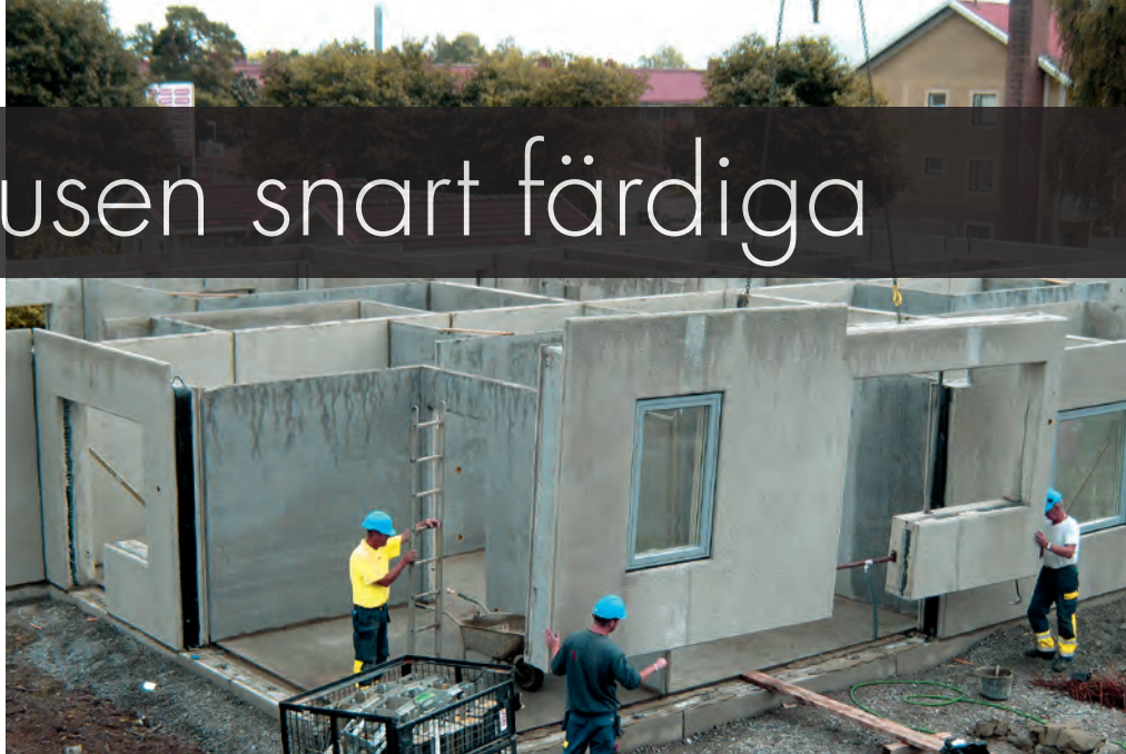
Montage av yttervägg, Iggesund
