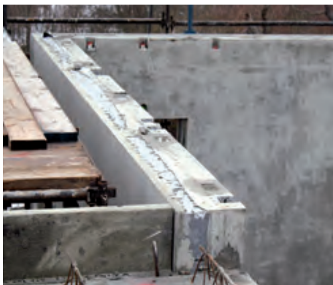
En monterad sandwichvägg, d.v.s. en vägg med cellplast (220mm) mellan två betongskivor.
