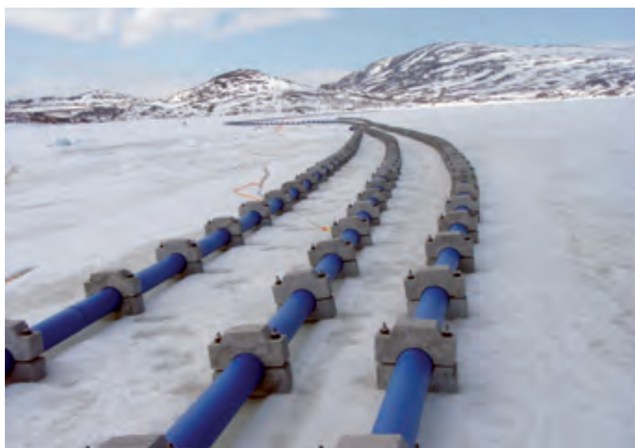
Utläggning av sjunkvikter på is. Projekt Riksgränsen, utfört av LL-dyk i Luleå.
