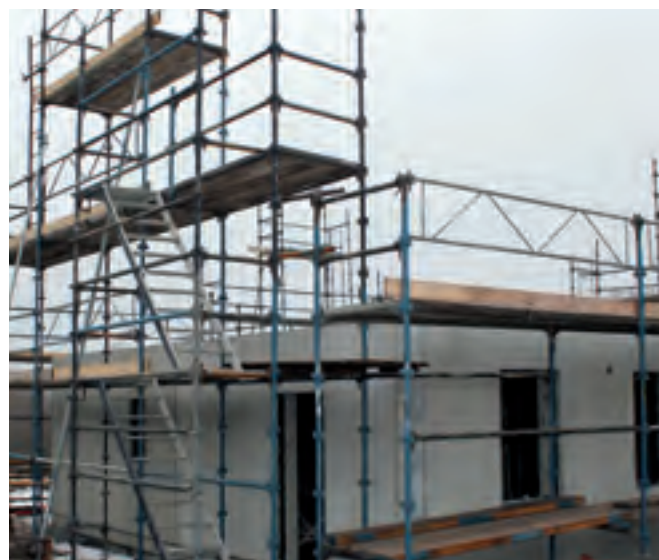
Bottenvåningen i Villa Thuresson. LK Fasadvägg levereras färdigt med dörr- och fönsterhåll.
