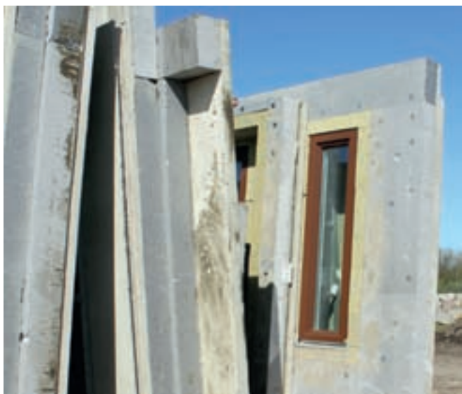
Bakmursvägg - en bärande yttervägg, här med färdigmonterade fönster.
