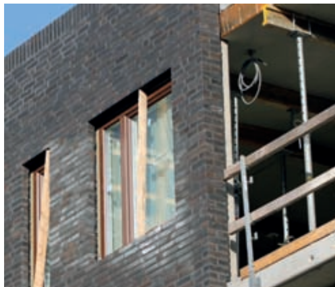
Bakmursväggen har fått en tegelbeklädning.
